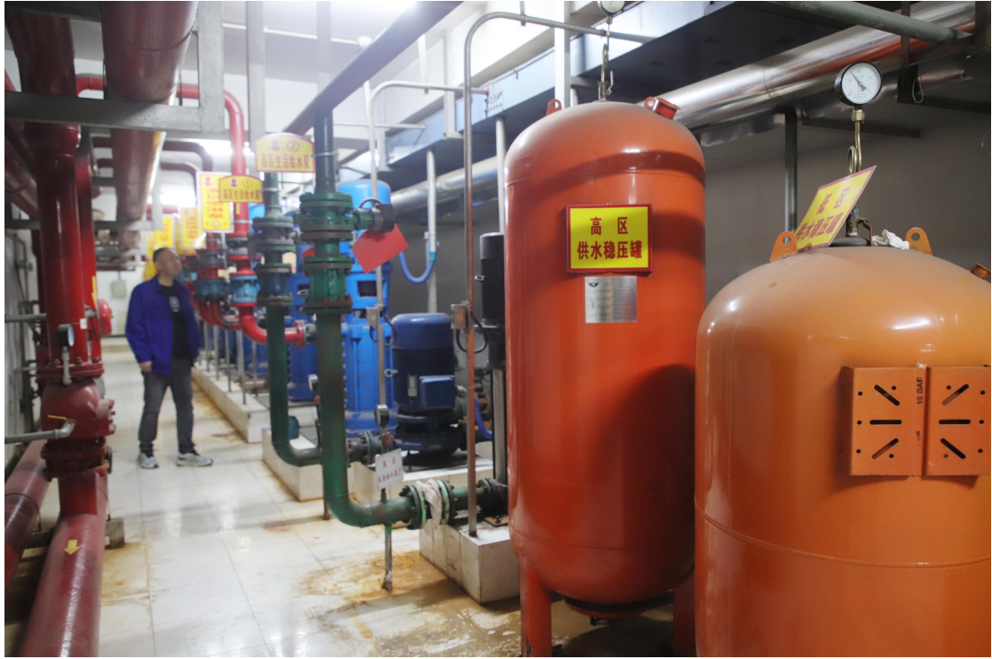
高层供水设备安全检查
