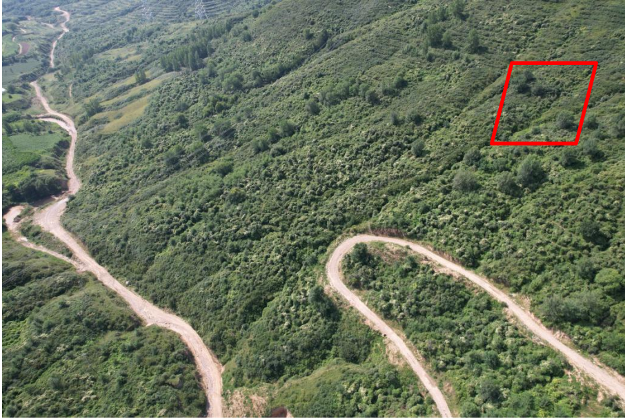
塔基区及塔基施工区
